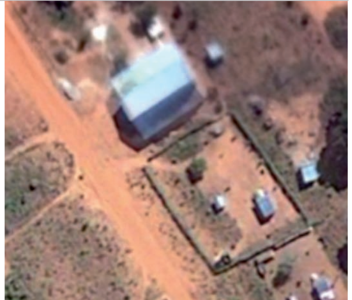
Foto aerea dell'abitato di Panda
